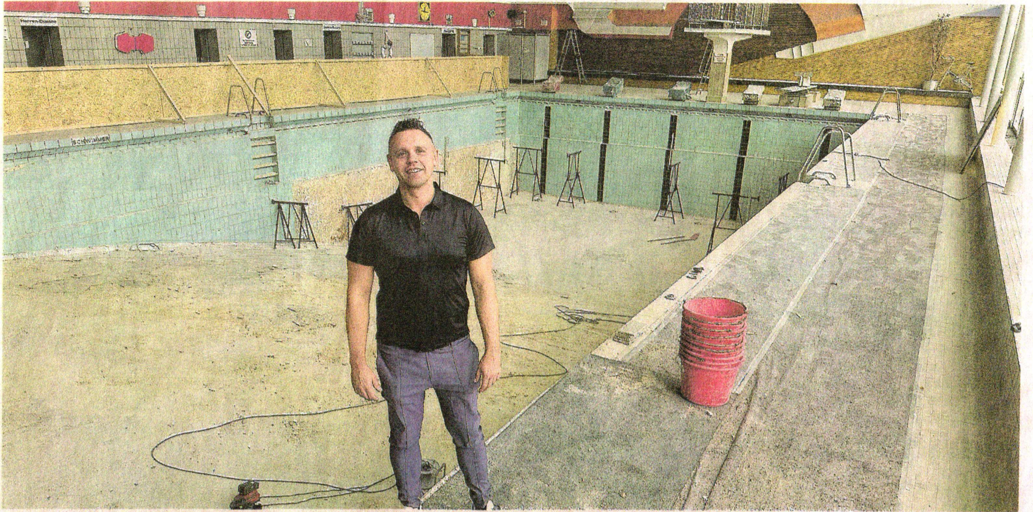
Der erste Vorsitzende des SSC Hörde, Benny Bartel, vor der riesigen Baustelle im Hörder Hallenbad: Das große Becken muss erneuert werden.
